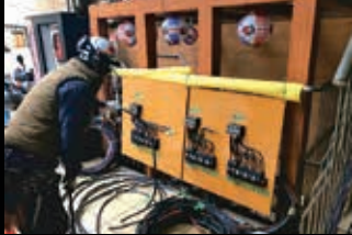
● 仮設分電盤 設置工事
