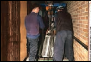
● 仮設分電盤 設置工事
