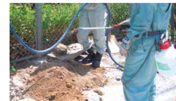
(噴霧器による水の噴霧作業)
