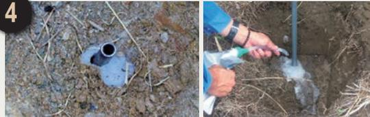
スラストパイプの上部が少し見える程度で打ち込みを終えてください。1本目のスラストパイプ打ち込みは終了です。
