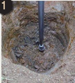
750mm以上の規定深度にφ500mm程度の掘削穴を掘り、ブレイクアローとスラストパイプを繋いで、掘削穴の中心部に差し込みます。
